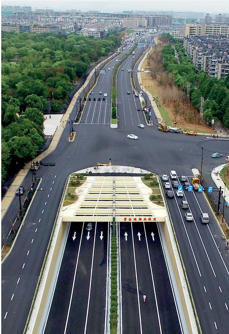
紫金港路南隧道。
