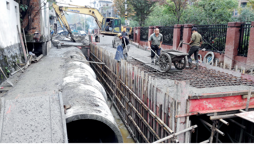
工地上正在浇筑箱涵。
