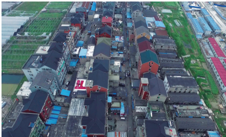
乔司街道三角村1组拆前
