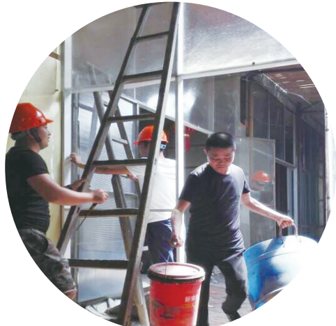
新联村董财根正在搬迁腾地，“党建+推项目”机制，大大提升城际铁路项目的推进速度
