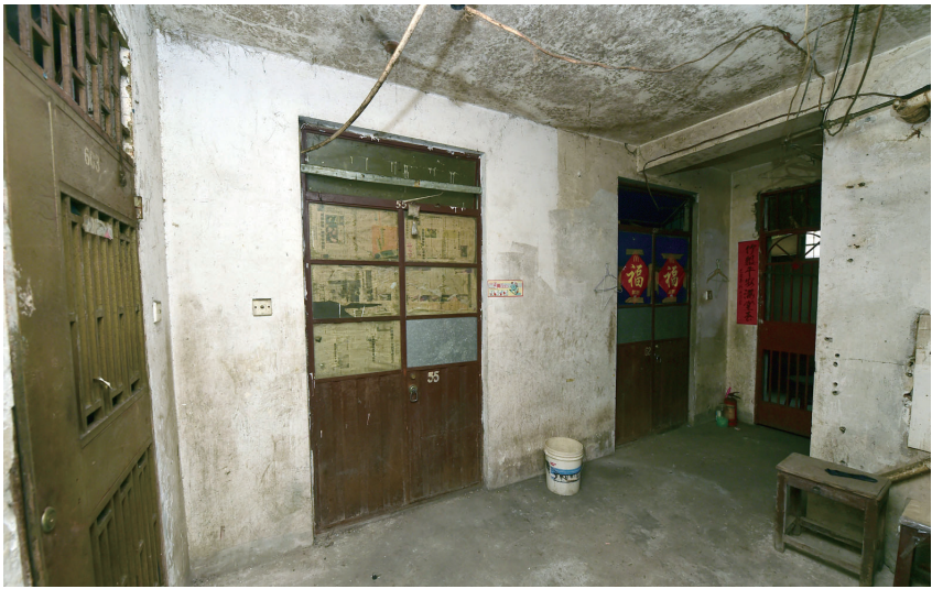
永康苑小区34幢地下室原貌。
