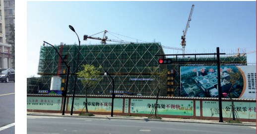
施工中的市中医院丁桥分院
