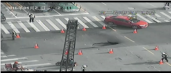
裂缝变成塌陷
