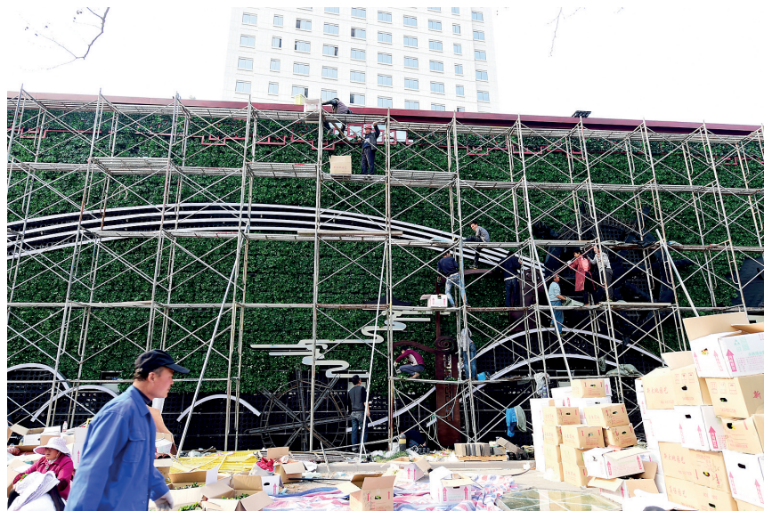
《最美运河》立体车库生态墙。 记者 李忠 摄
