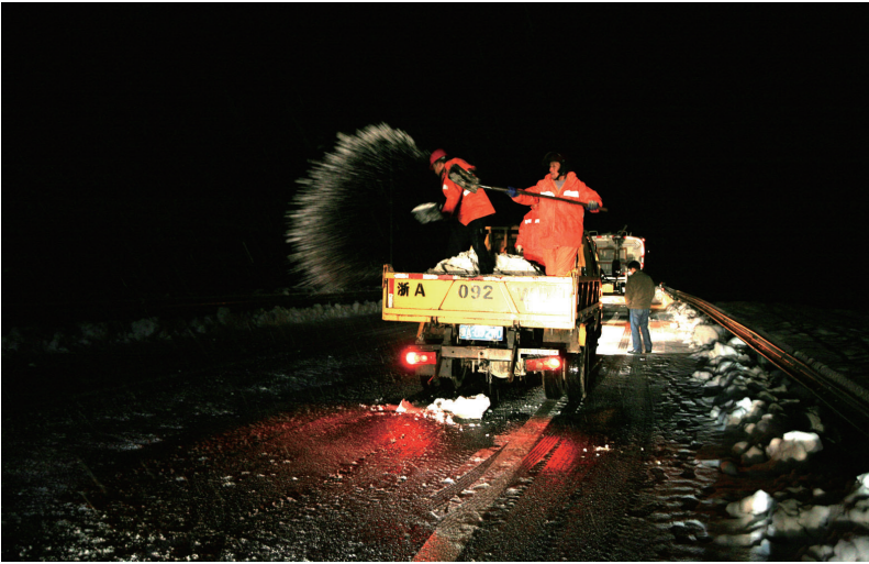
淳安302省道,公路部门正在进行撒盐融雪防冰冻作业。
