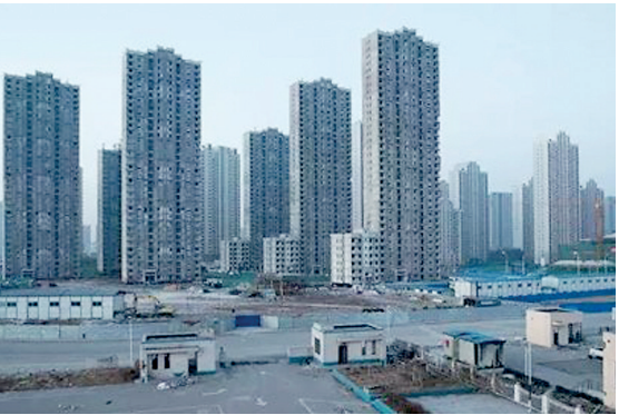
今年2月4日,爆炸点南侧的小区正在复建。
