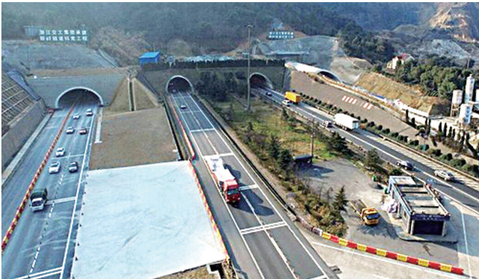
拓宽后的新岭隧道。
