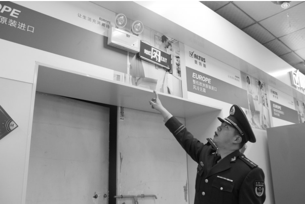
五星电器二楼南侧商铺采用大量木板和少量泡沫板装修
