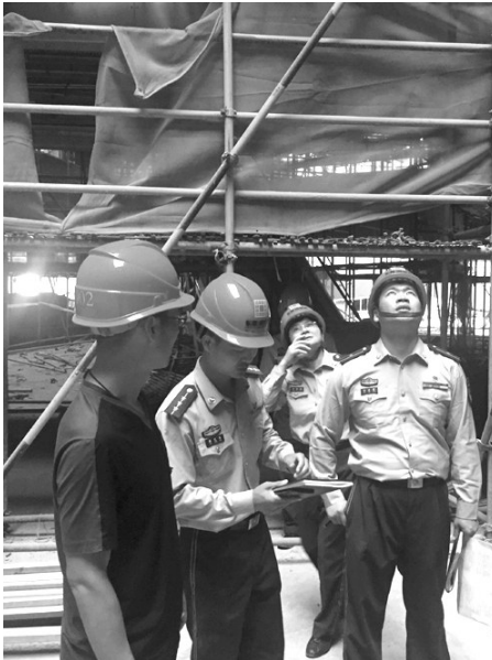
消防支队工作人员主动到施工现场指导工作
