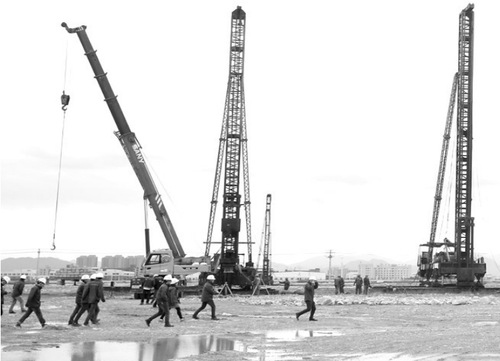
温州威马产业园工地现场
