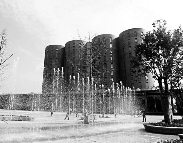
科技城的“4根烟囱”主建筑
