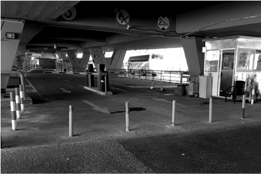
停车场门口的隔离桩今天就要拆掉了
