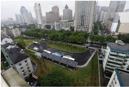
6月11日，白鹿鞋城旧址上改建的公交首末站投入使用
