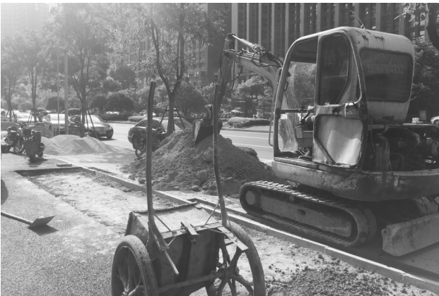
挖掘机正在作业
