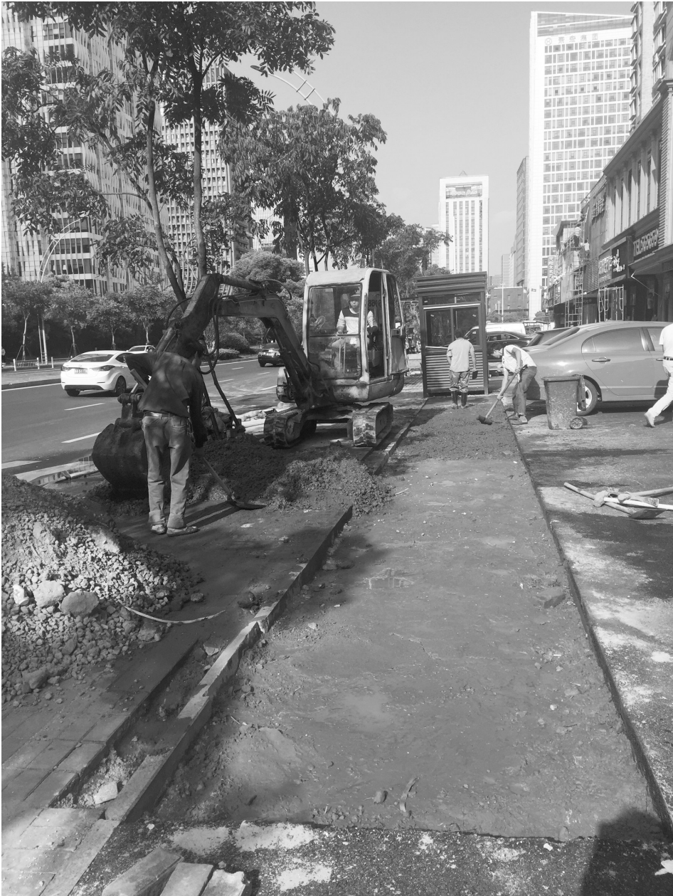
商铺前的10多片绿化带已经被铲除,岗亭已经到位。
