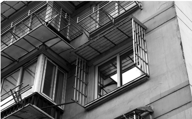
发生事故的房间外墙，防盗窗的正面和底面已随大姐坠下。记者 葛亚琪 摄
