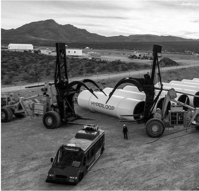
Hyperloop One公司公布的测试场施工照片
