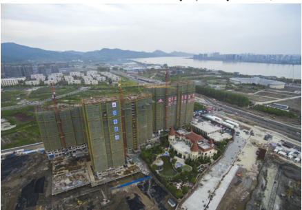
正在建设中的恒大水晶国际广场
