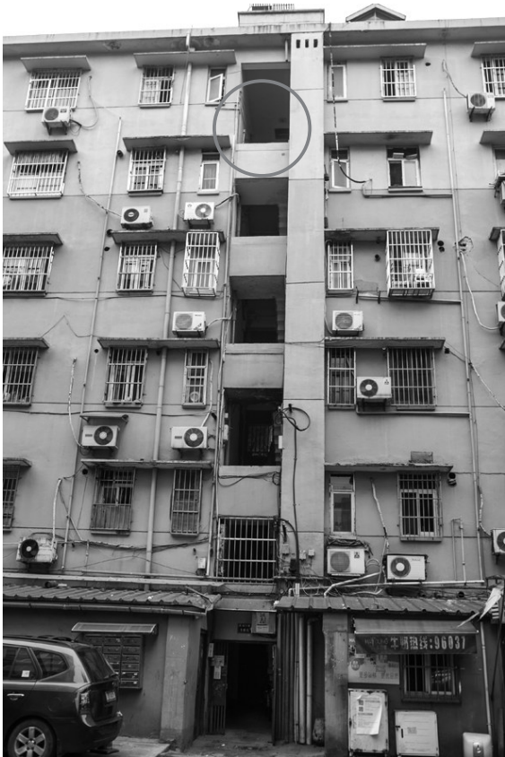
艮园5幢,女子是从5楼和6楼之间的楼道窗口(画圈处)坠下的。
