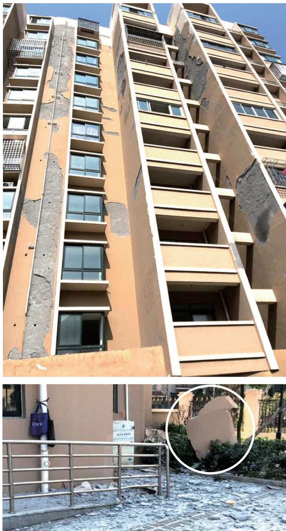
脱落的墙面砸进了绿化带
