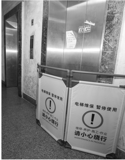
电梯门前放着警示围栏 记者 陈中秋 摄
